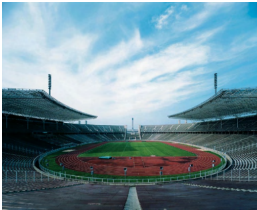
Abbildung 23 links: Olympiastadion Umbau von 1974
