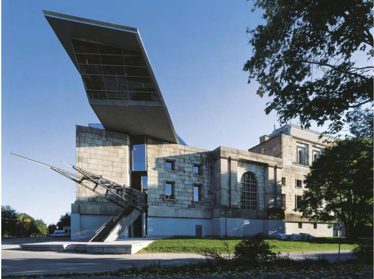
Abbildung 13 Eingangsbereich im Nordflügel - Dokumentationszentrum Nürnberg
