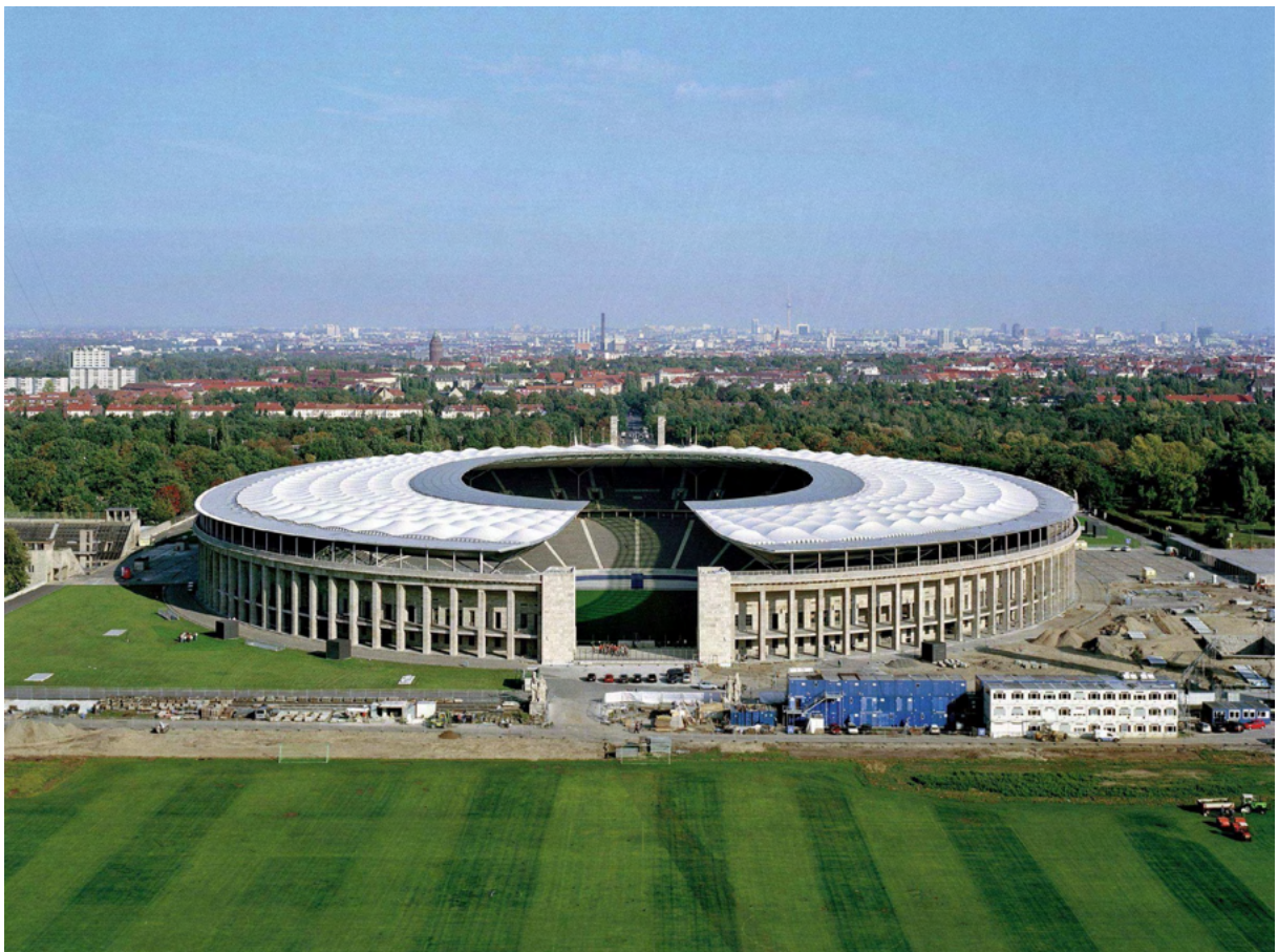
Abbildung 22 Olympiastadion während der Sanierungsarbeiten
