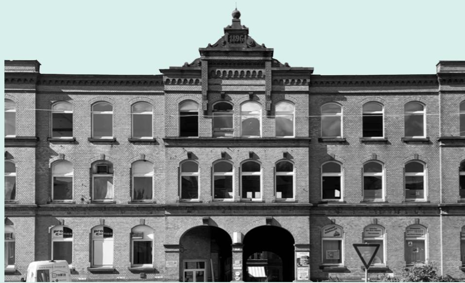
Abb. 27. Schauseite zur Langenfelderstraße, 1896
