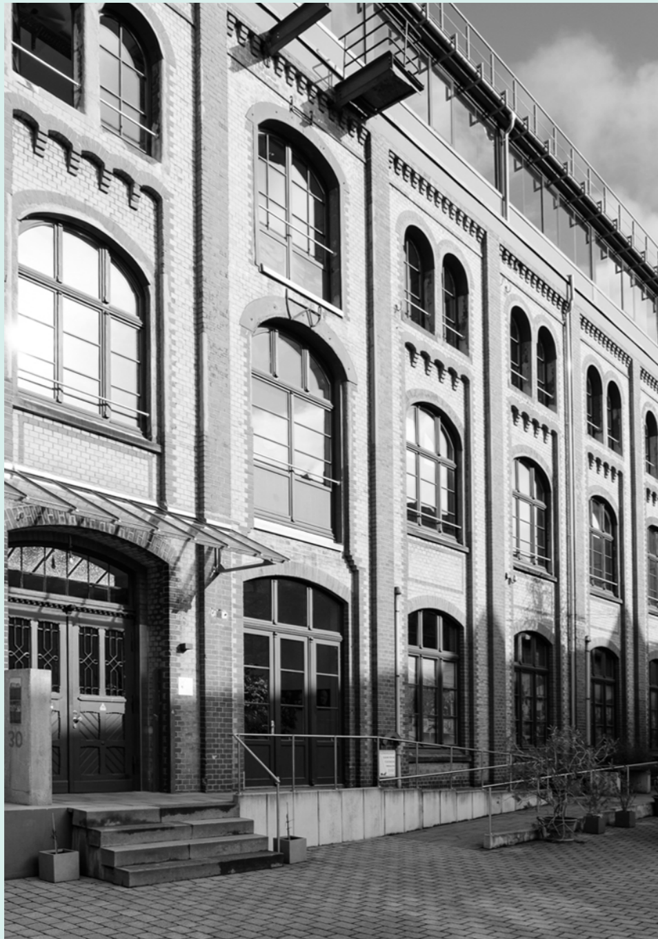
Abb.19. Fassade vom Innenhof
