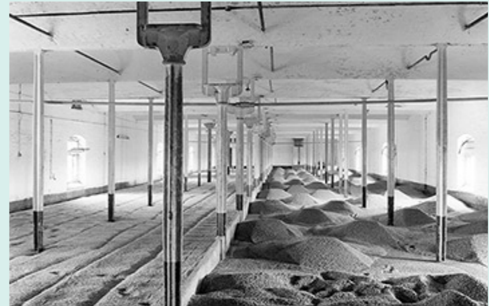
Abb. 52. Ditherton Flax Mill, Architekt Charles Bage, 1797
