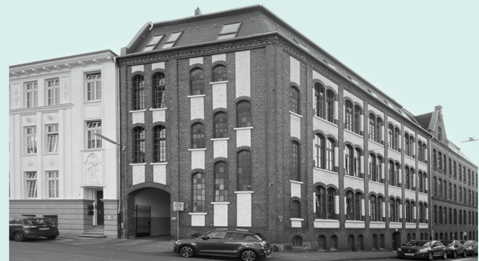
Abb. 47. Bandfabrik W. Schüller & Sohn GmbH, 1902/1908
