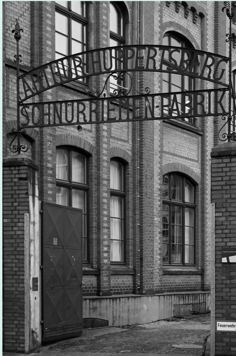
Abb.20. Eingangsfoto der Steindruck-Fabrik
