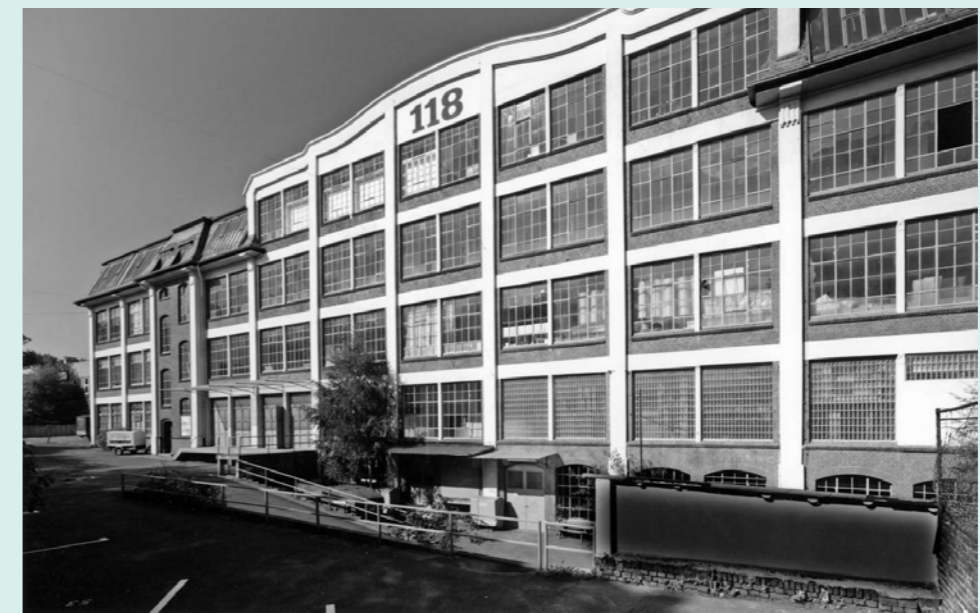
Abb. 54. Stahlskelettbau: Gold-Zack-Werk, Wiesenstraße 118, 1910
