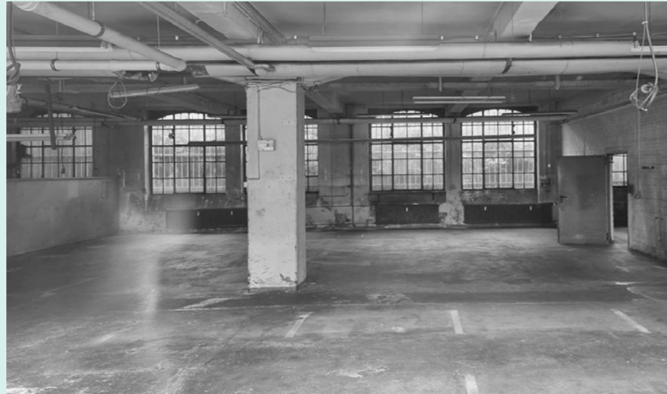
Abb. 7. Bestandsfoto: Erdgeschoss im Leerstand
