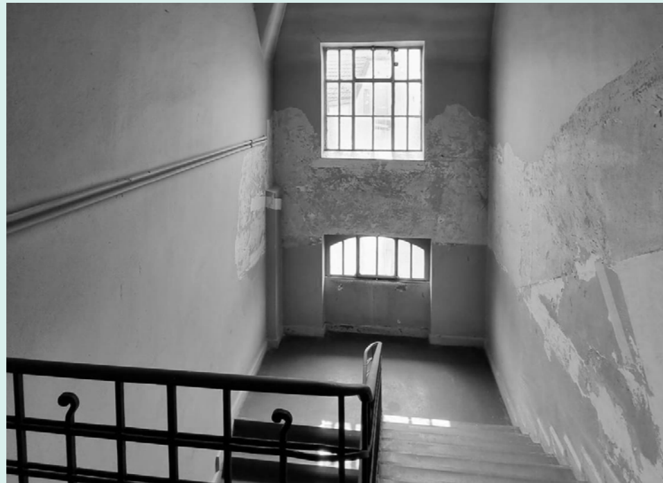
Abb. 8. Bestandsfoto: Treppenhaus vom Museum
