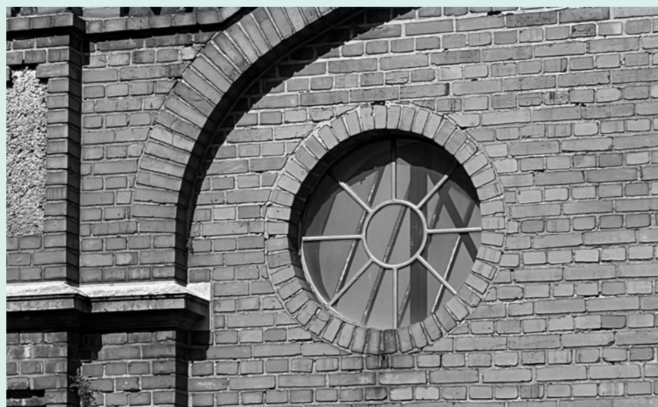
Abb. 20. Detailaufnahme des sichtbaren Sheddachs
